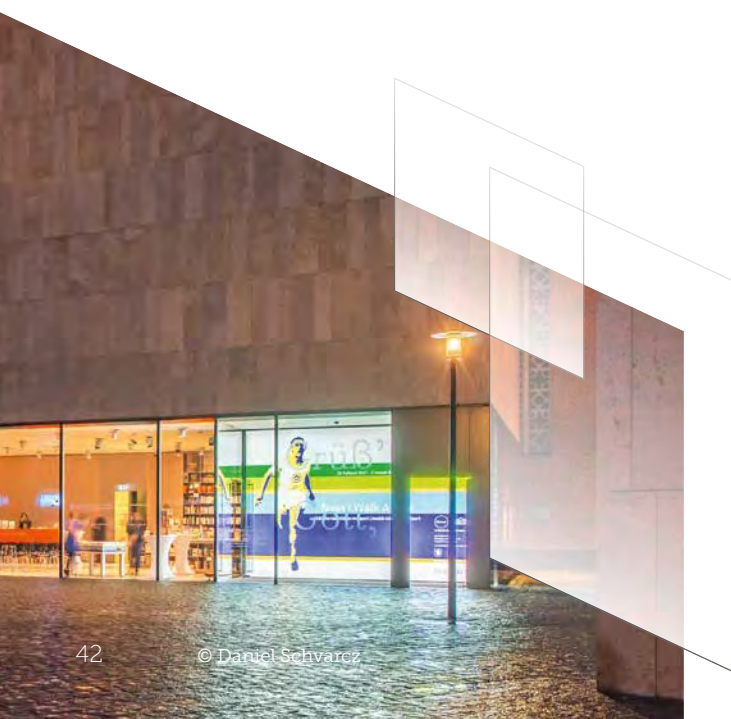
Jüdisches Museum, München Jewish Museum, Munich: Structural Glazing Stahl-Aufsatz- fassade rp tec 55-1 mit rp tec 55-1 SG Structural glazing steel add-on façade rp tec 55-1 with rp tec 55-1 SG
